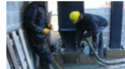
Verfüllen von Stahlstützen in einem Parkhaus
