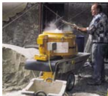
Befüllen der S 5 EV per Schaufel
