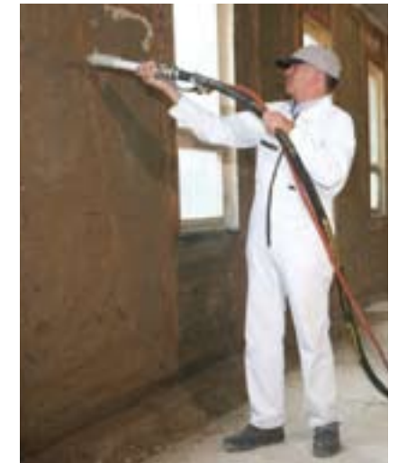
Lehmputz spritzen im Innenbereich
